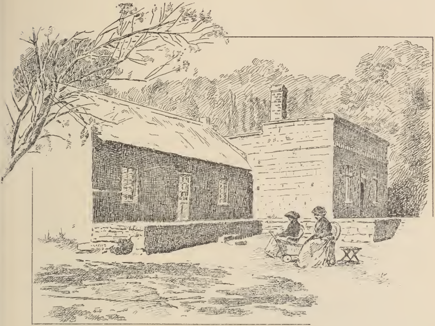
Léribé — La maison de Coillard
